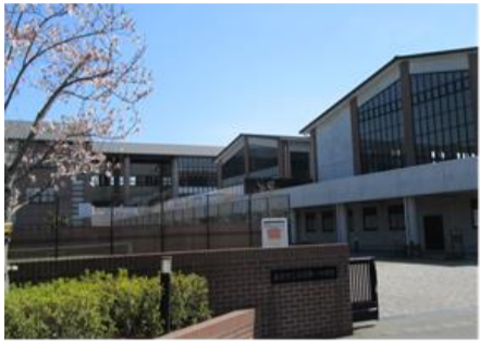
煉瓦調のモダンな校舎建築
